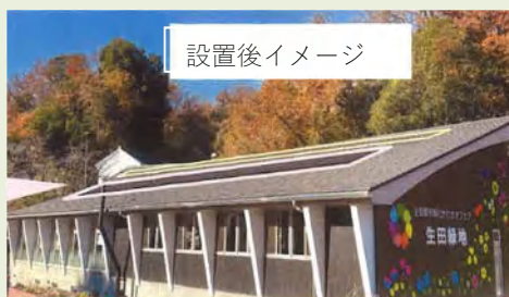
太陽光パネル
